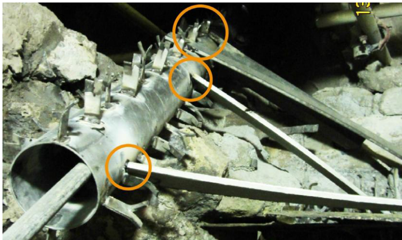
Abb. 23: Schutzrohr im Inneren des Drehrohrofens mit Stabilisierungsmaterial gesichert
