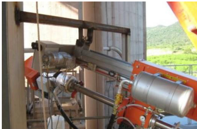
Abb. 28: Montage an der Haltestange (Beispiel)
