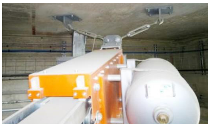
Abb. 29: Montage an der Decke (Beispiel)
