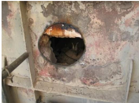
Abb. 20: Öffnung in der Einlaufkammer (Beispiel)
