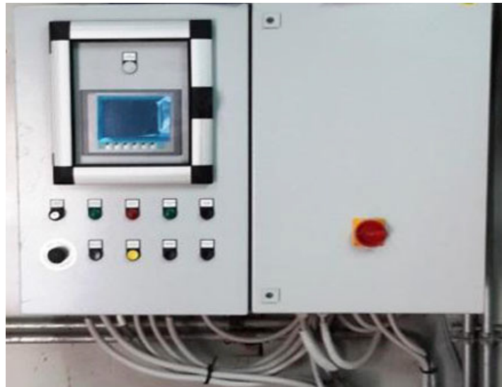
Abb. 36: Installierter Schaltschrank
