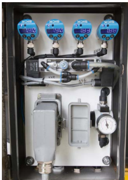
Vier druksensoren PBS bewaken druk en onderdruk
