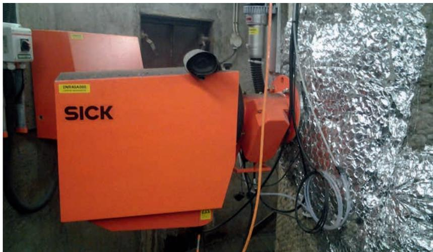
Der In-situ-IR-Gasanalysator GM35 ist am Schornstein angebracht und ermittelt die CO<sub>2</sub>-Konzentration direkt im Abgaskanal
