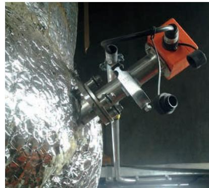
Das Volumenstrom-Messgerät FLOWSIC100 misst die Strömungsgeschwindigkeit der Gase
