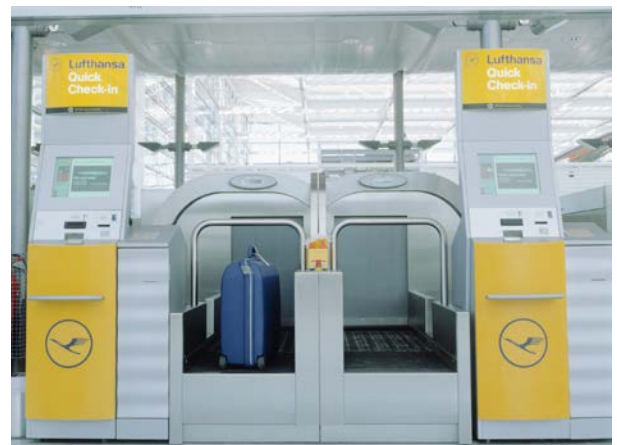
Abbildung 1: Kombinationen der Technologien RFID und Laserscanner kommen beispielsweise an Flughäfen in Gepäckidentifikationssystemen für die Gepäcksortierung (links) und in Self-Bag Drops (rechts) zum Einsatz.
