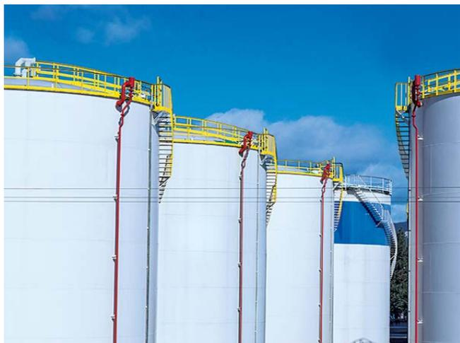
石化厂的大多数原料和终产品均储存于大型储罐区中。其中许多为可燃物质,因而在氧气存在时有迫在眉睫的爆炸危险。为避免形成易爆气体氛围,管道和储罐需要由氮气或  $\text{CO}_2$  等惰性气体吹扫并加压。通常由氧气分析仪监测这一惰化或覆盖过程,其可检测到任何残余氧气。同时可借助分析仪将惰性气体消耗量和惰化过程持续时间降至最低。
