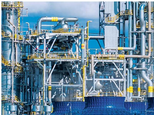
尿素设备通常紧邻氨设备,因为其可以提供  $CO_2$  和  $NH_3$  原料。这些成分在高压下反应生成氨基甲酸铵,后者作为中间产物缓慢分解为尿素和水。氨基甲酸酯溶液具有强腐蚀性,因此需要持续通入少量空气,以形成保护金属表面的钝化氧化膜。SICK 可为监测钝化过程和烟囱处粉尘、氨和水的排放情况提供解决方案。
